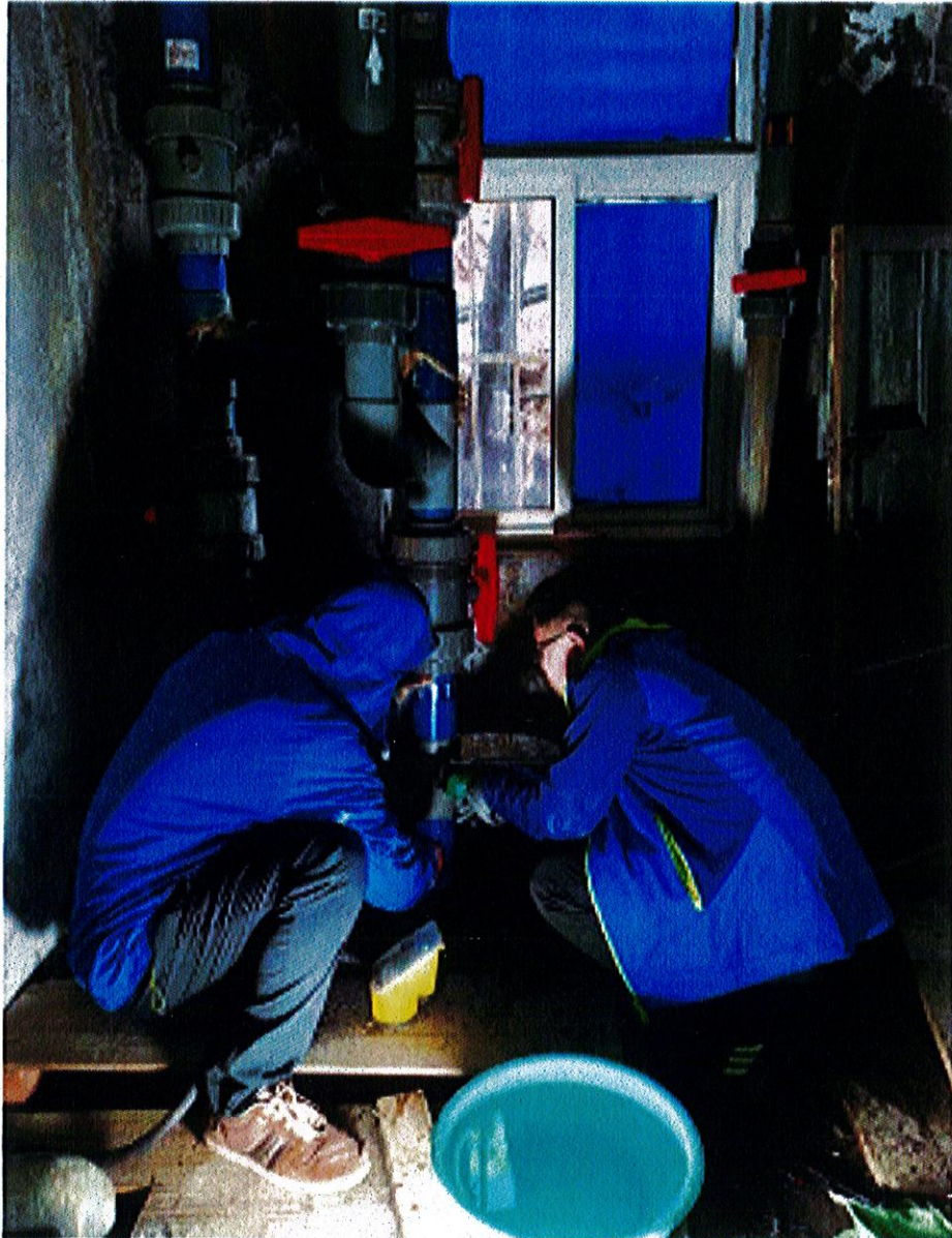
供水管道改造
